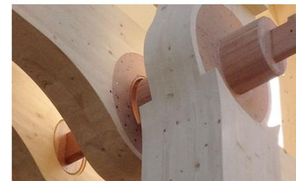
Das Tragwerk besteht aus 4 Stützen in Quer- und 8 Stützen in Längsrichtung, woran die 10 bestehenden Zangen angeschlossen worden sind. Diese wurden jeweils paarweise an Vor- und Rückseite jeder Stütze eingehängt.
