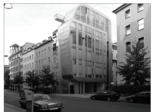
Hessische Strasse 5, Deadline Office
